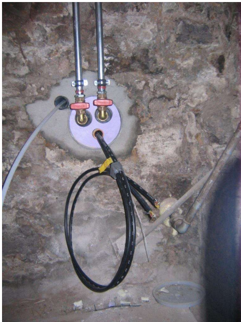
Hauseinführung mit Absperreinrichtung
